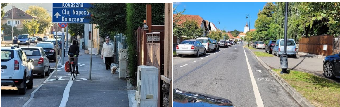
Lățimea insuficientă a pistelor pentru biciclete
